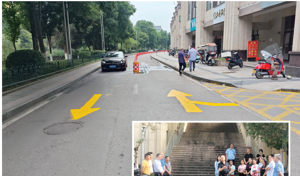
▲ 整改后的道路。
