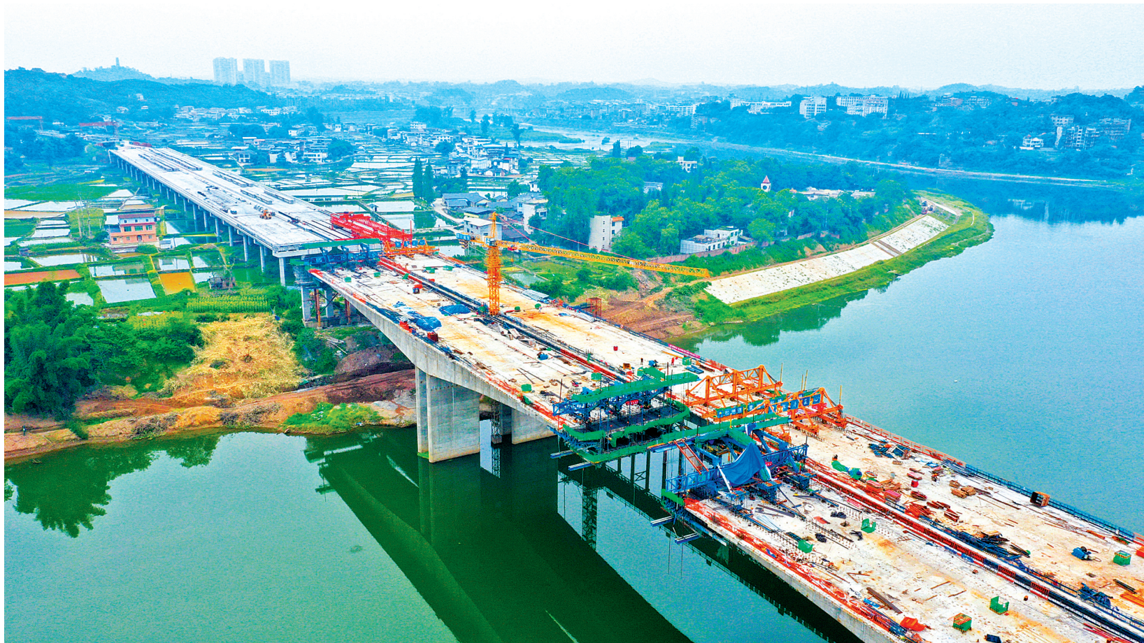
福源灏特大桥建设现场
