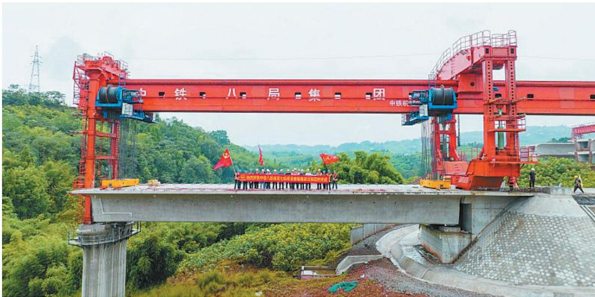
四川日报讯(四川日报全媒体记者 阙莹莹)7月9日10时20分,随着一榀长32.6米、重达790余吨的预制箱梁稳稳落在新吉村4号大桥桥台上,渝昆高铁宜宾至筠连段首榀预制箱梁架设顺利完成。这也标志着全长84.9公里的渝昆高铁宜宾至筠连段正式进入架梁阶段。
