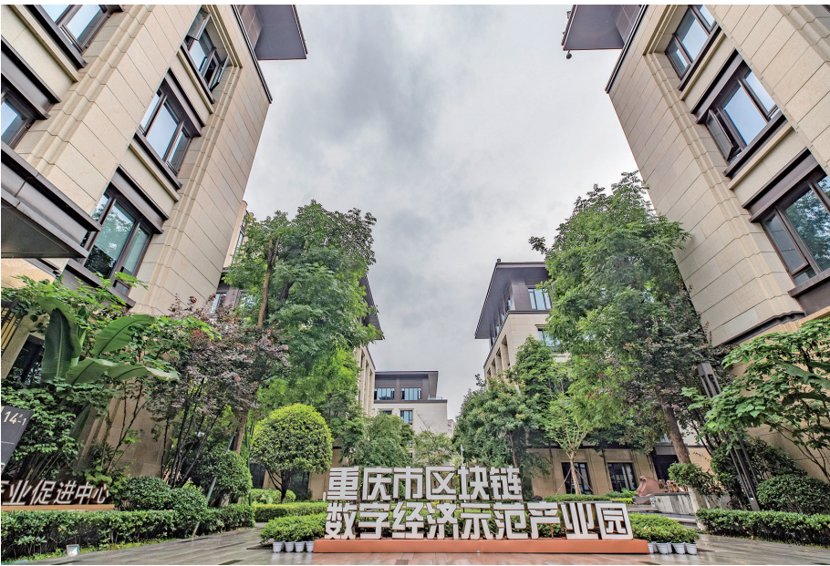
重庆市区块链数字经济示范产业园。
