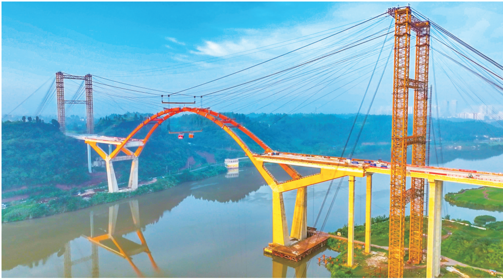
东升大桥钢结构主拱合龙进行中。
