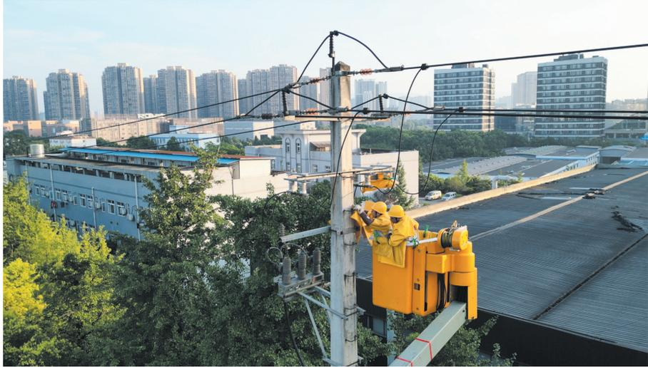
电力员工带电作业消除10千伏线路设备隐患
