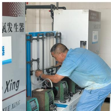
三水厂负责人对加药间的二氧化氯发生器加药管进行维修更换工作
