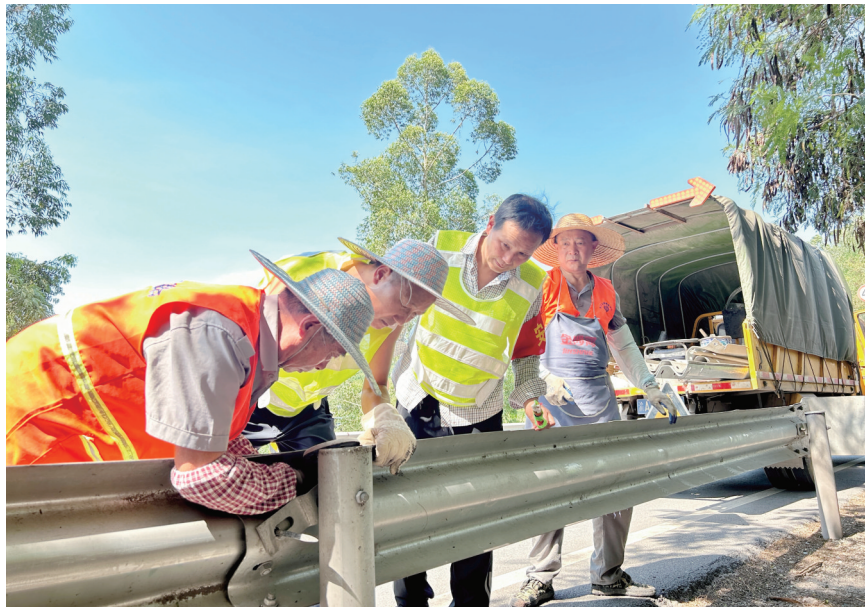
安保组队员合力安装波形护栏。
