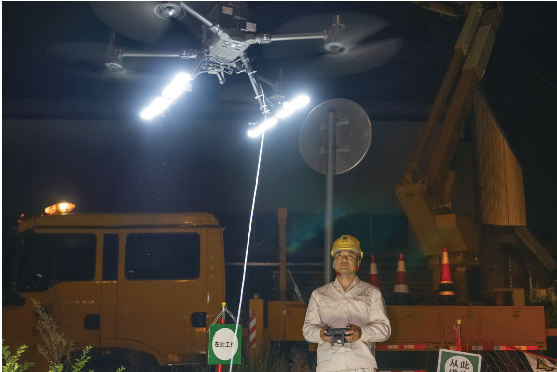
工作人员操作无人机配灯为不停电作业照明。
