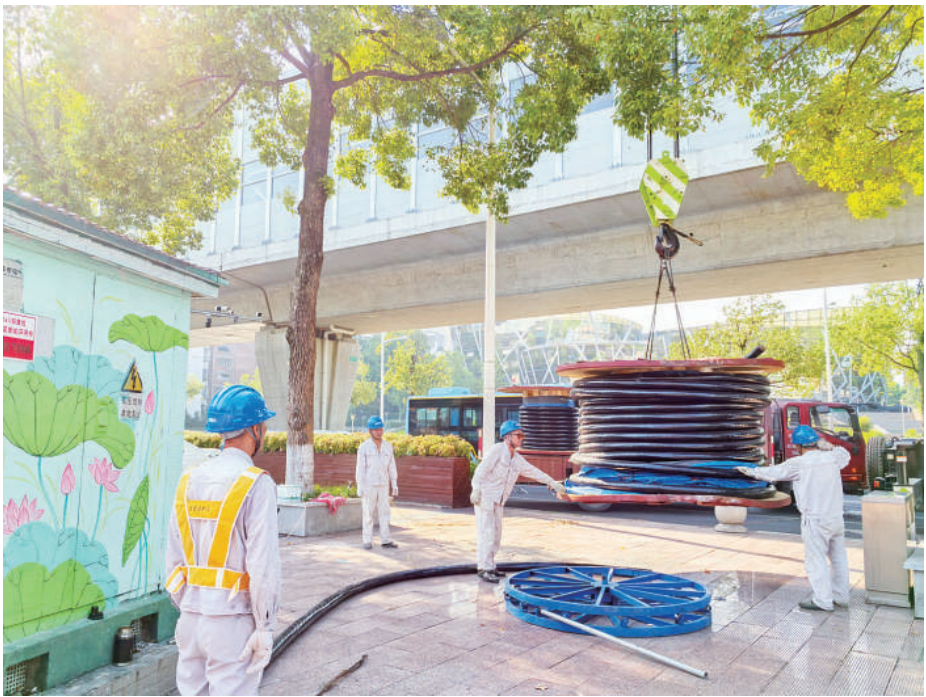
电力工人正在开展小区双电源改造工作。
