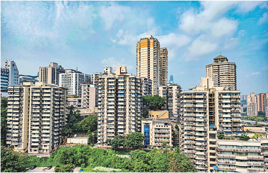
新都巷片区老旧小区改造提升项目本体完工,老旧楼栋穿上“新衣”。
