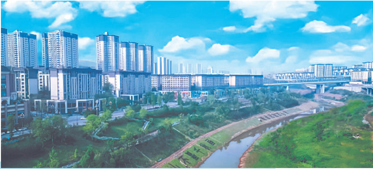
►项目水生态修复节点工程一角。
