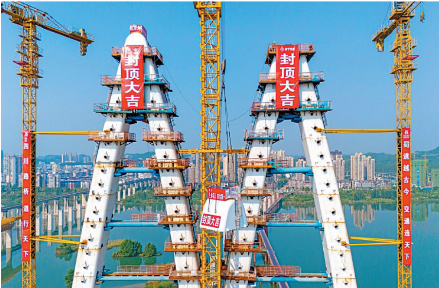
涪江六桥主塔封顶。
