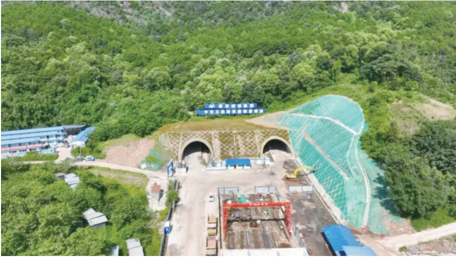
陶家隧道项目施工现场。
