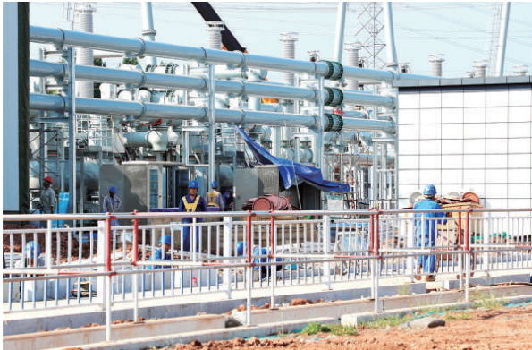
工人正在进行附属设施施工
