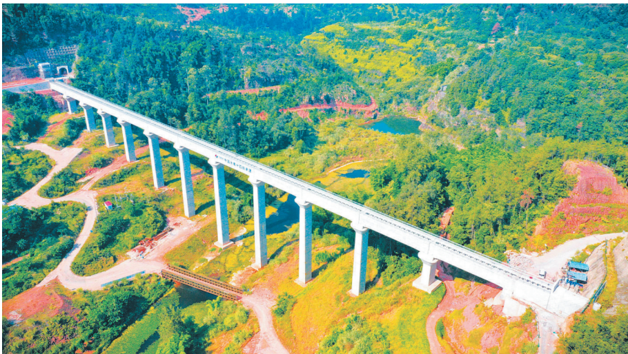
邱场分干渠(自贡段)工程
