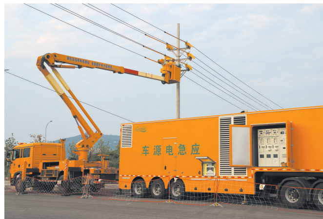
双方协同开展不停电作业现场
