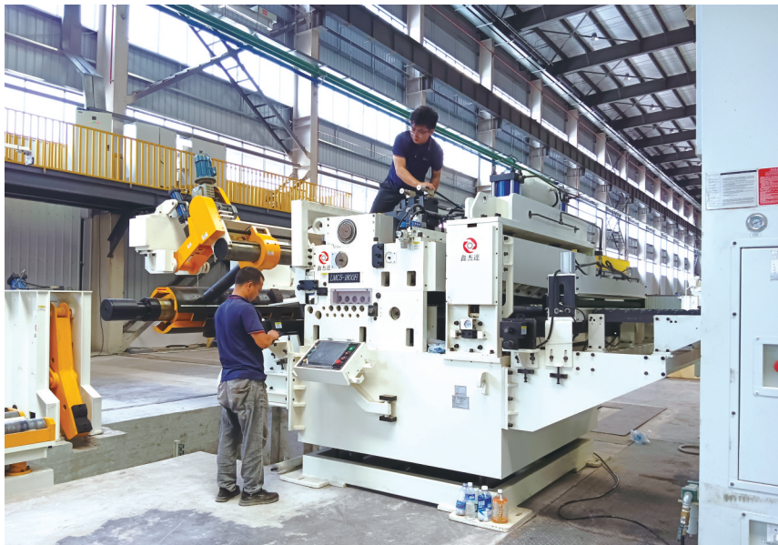
工人正在安装调试设备
