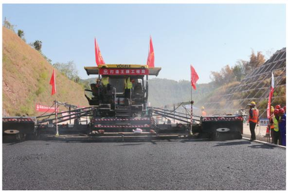
本报讯(渝西都市报记者钟梅陈巍通讯员曹远华文/图)永川至璧山高速公路是永川与璧山之间的重要联络线,是重庆市高速公路网重要组成部分。9月19日上午10时,在永璧高速公路项目施工现场,运输车往返穿梭,摊铺机、压路机等各类机械作业有条不紊。经过紧张有序的施工,由中铁五局承建的永璧高速项目路面沥青下面层试验段顺利铺筑。沥青路面正式启动实施,标志着项目由半刚性基层向黑色路面正式开始转序,意味着项目正在向完成年底主线贯通目标又迈进了非常关键的一步。
