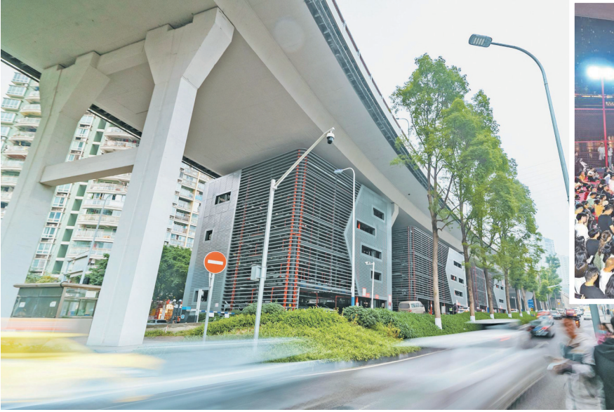
沙坪坝区石门大桥桥下机械停车库。(资料图片)
