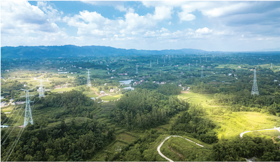
特高压送出工程永川段贯通
