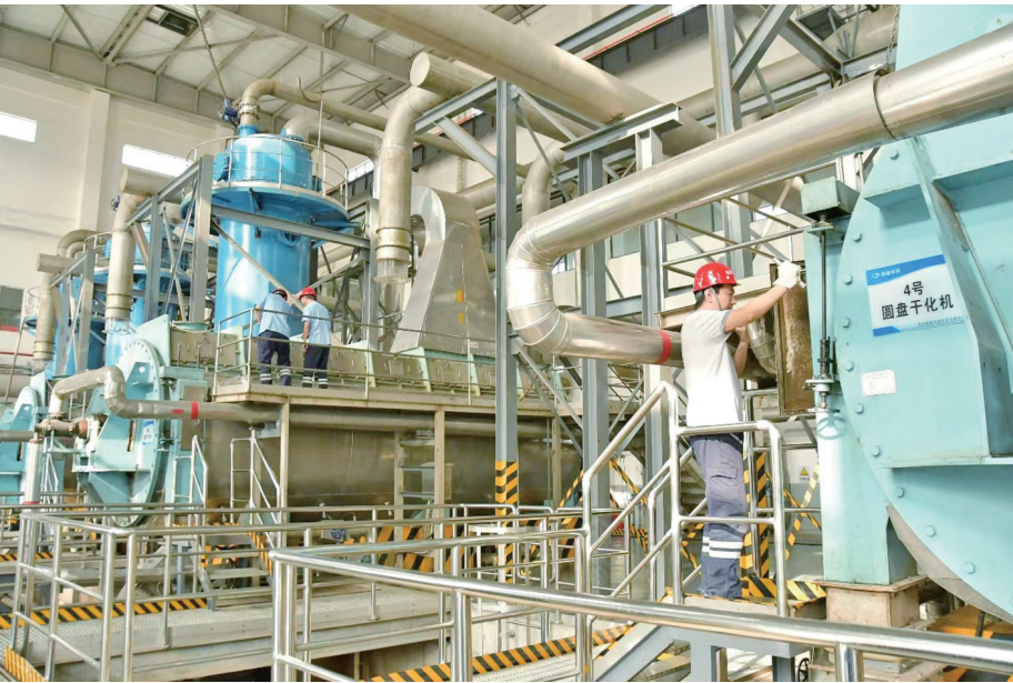
珞璜污泥处置中心生产车间
