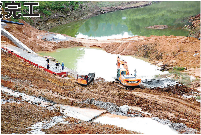
施工现场,工人们正在施工。
