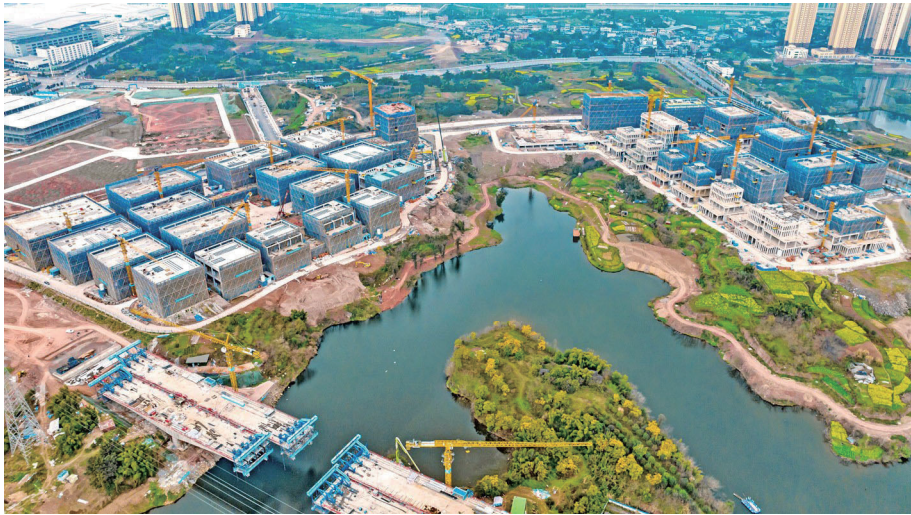
团结湖数字经济产业园建设现场
