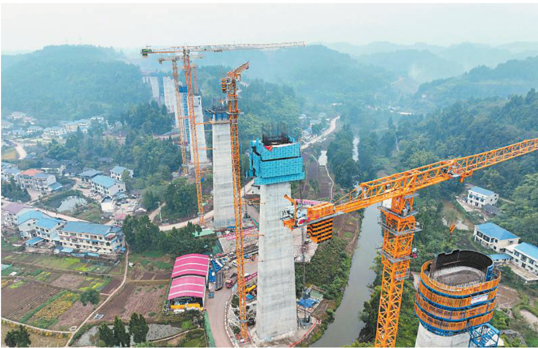
建设中的成渝中线高铁田柳湾特大桥。
