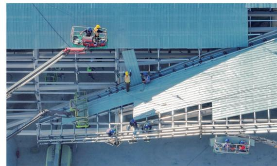
10月30日,工人正在进行正立面金属屋面施工。
