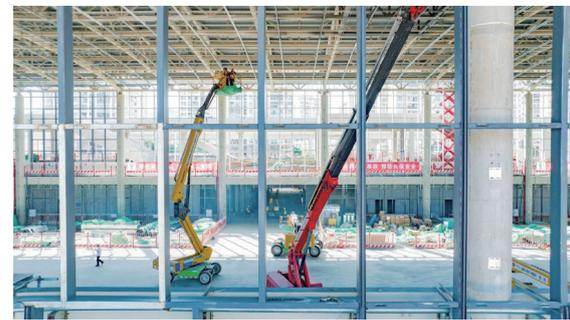
10月30日,工人正在进行候车厅吊顶龙骨施工。
