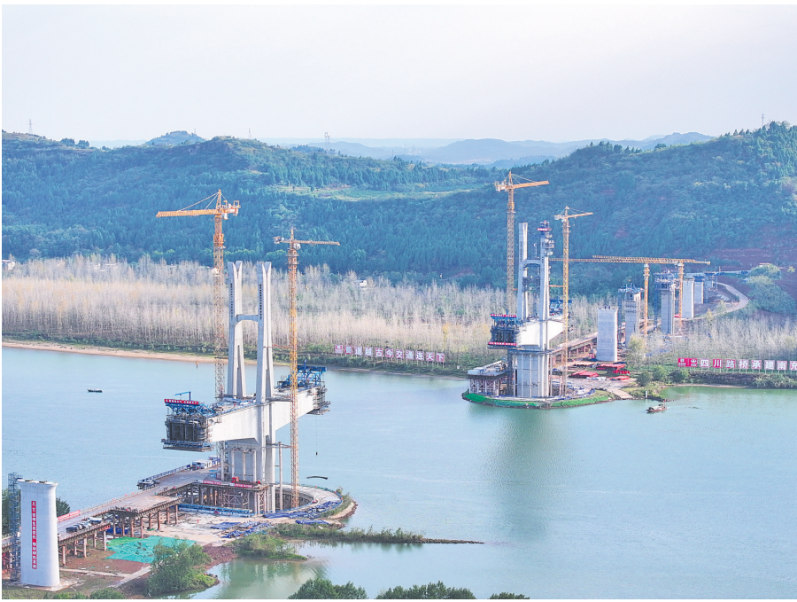
成达万高铁南充嘉陵江特大桥主墩实现封顶。
