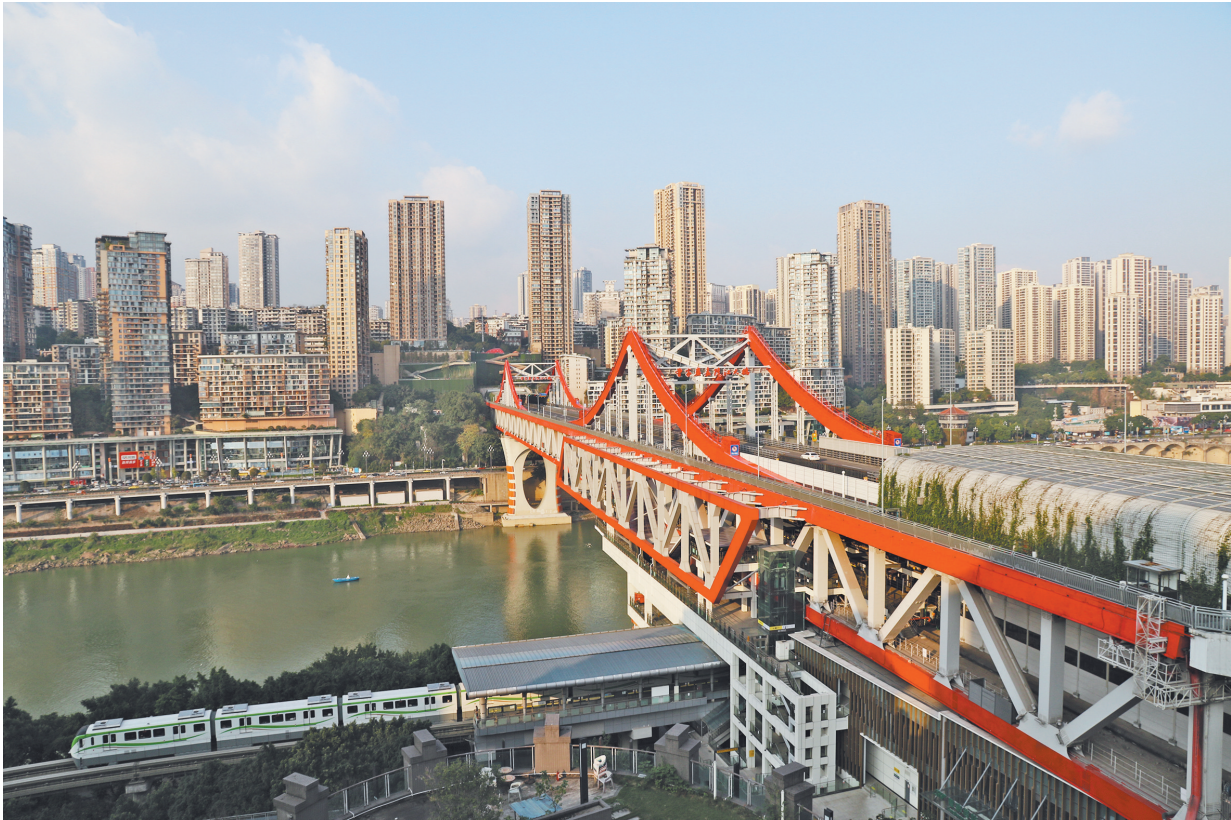
蓝天白云下的曾家岩大桥,轨道列车穿城而过,景色怡人。
