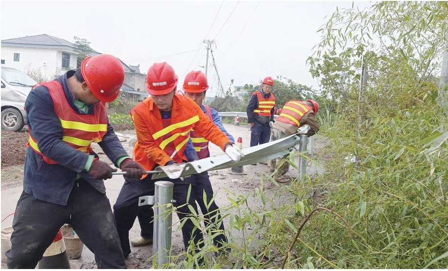
施工人员安装公路防护栏
