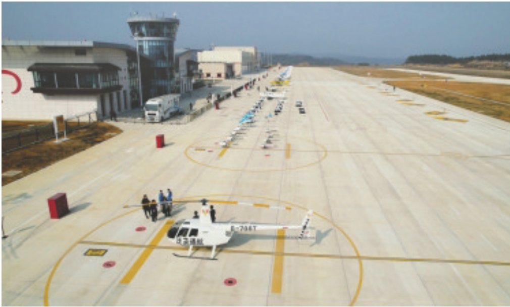
北川永昌机场停机坪(图片由北川永昌机场提供)
