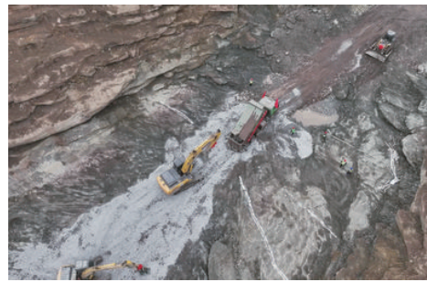
▲藻渡水库大坝填筑作业。 綦江日报记者 石汉谋 摄
