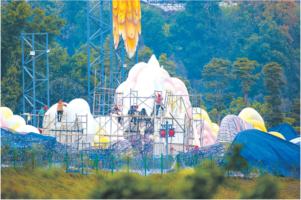
大型灯组制作现场。
