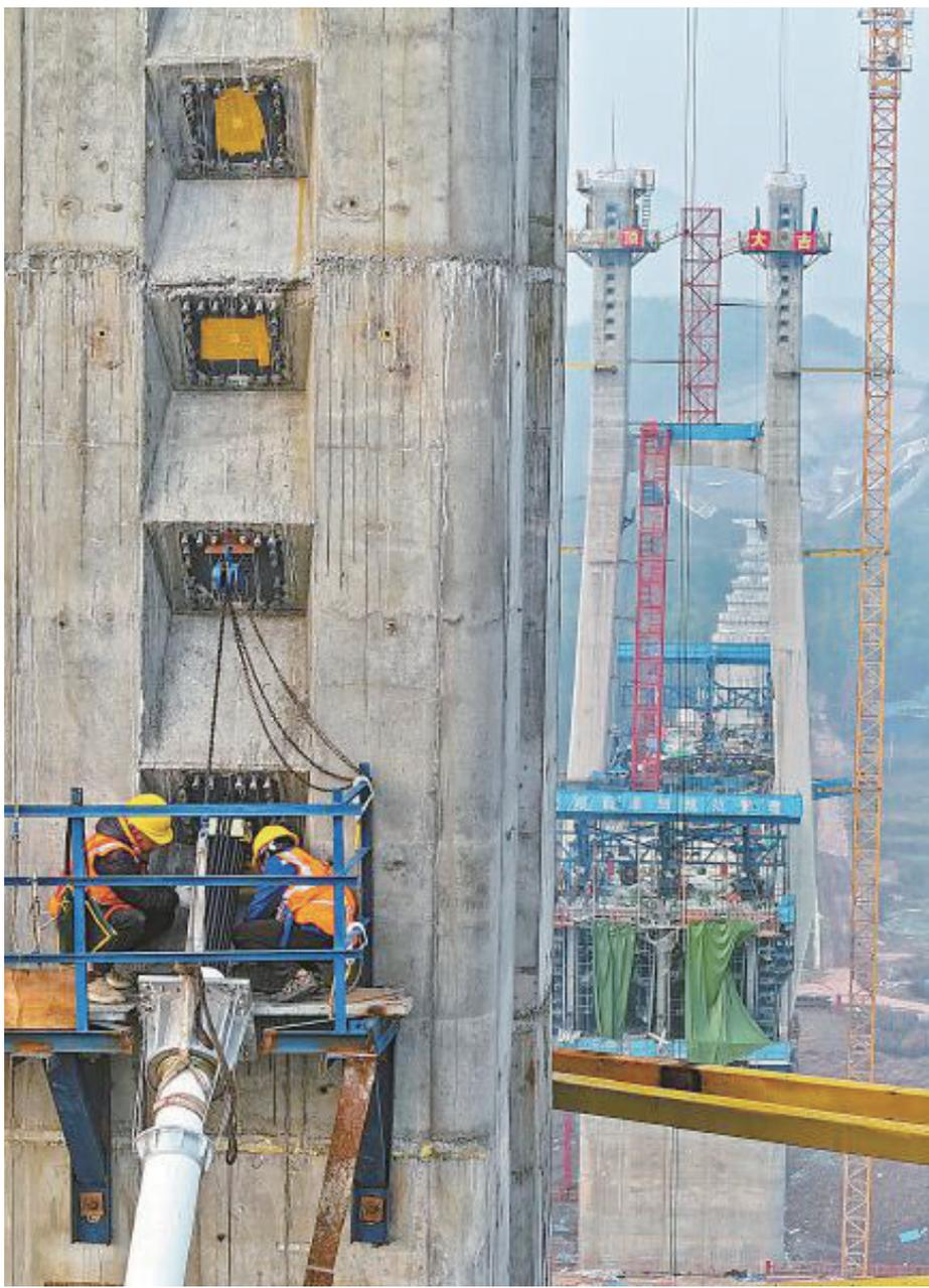
工人正在进行斜拉索的安装工作。
