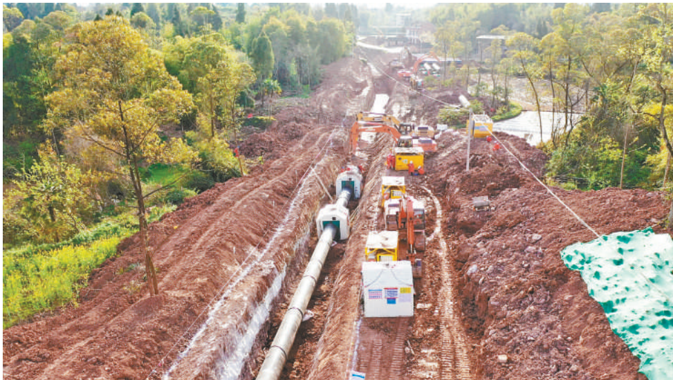
川渝鄂段一期工程施工现场。
