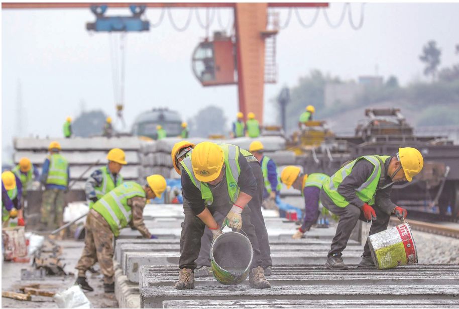
建设者们正忙碌地吊装轨枕。
