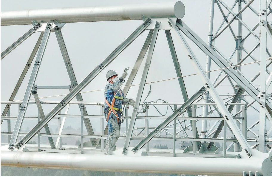
川渝特高压交流工程1000千伏铜梁变电站施工现场,施工人员正在涂装铁塔支架。(资料图片)
