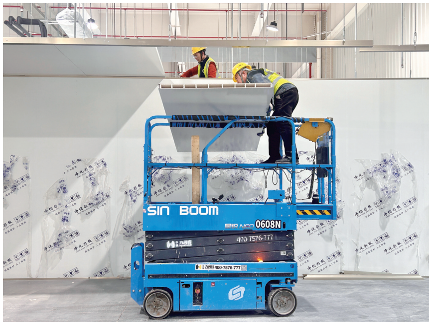
工人正在进行厂房室内装修。
