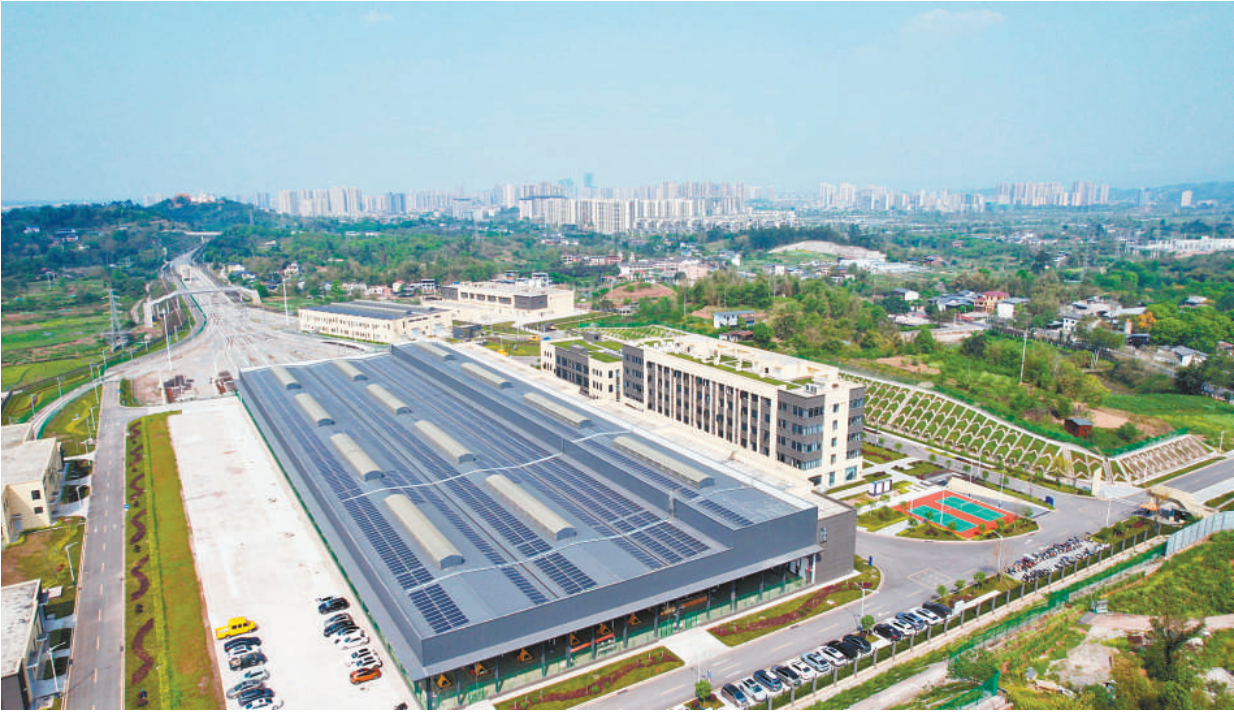
▲璧铜线停车场屋顶安装了光伏板。
