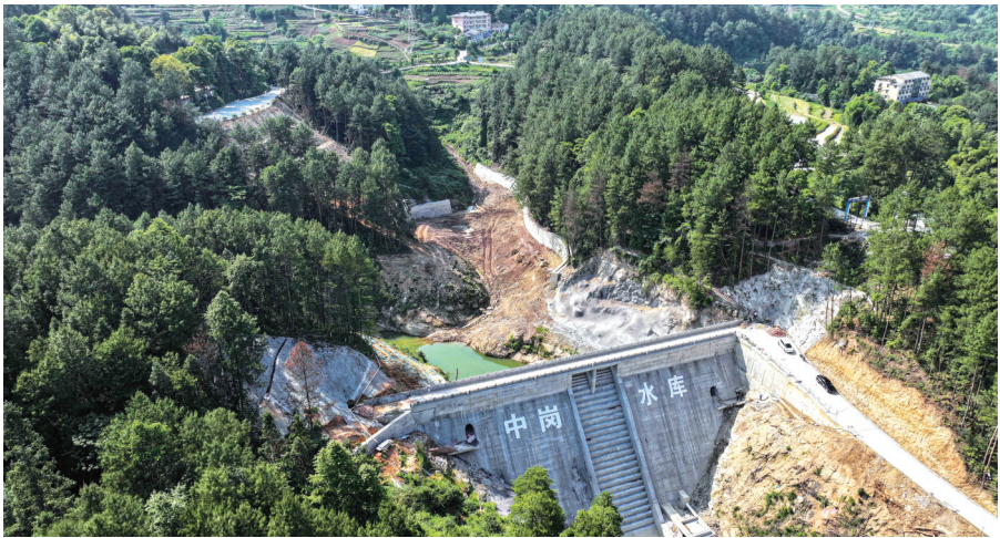
建设中的中岗水库。
