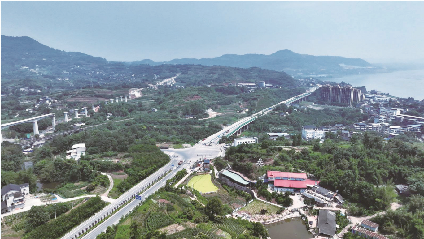
国道353线江阳段建设加快推进。
