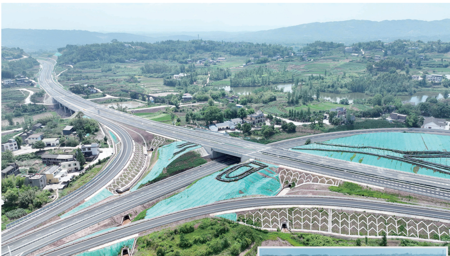
永璧高速公路金鼎互通。
