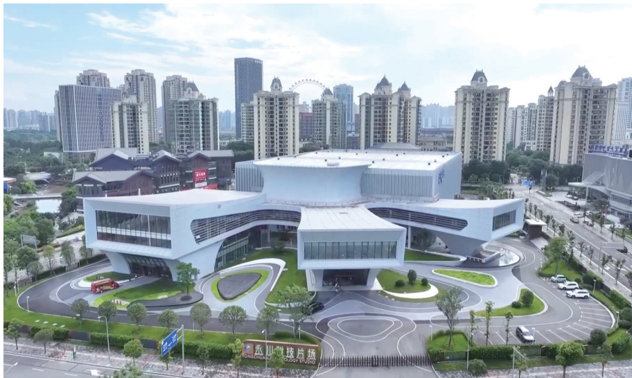
永川科技片场。
