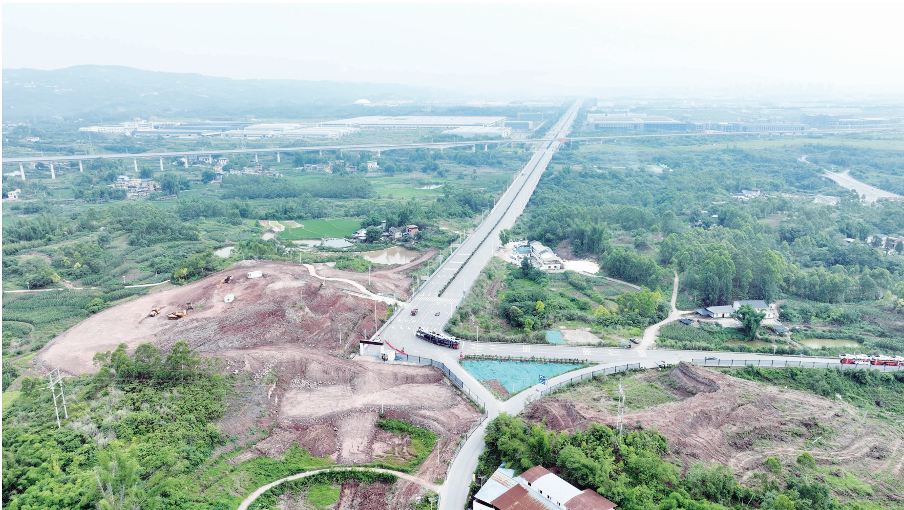
6月11日,渝西国际开放枢纽新城永川南立交与G246工程施工现场。
