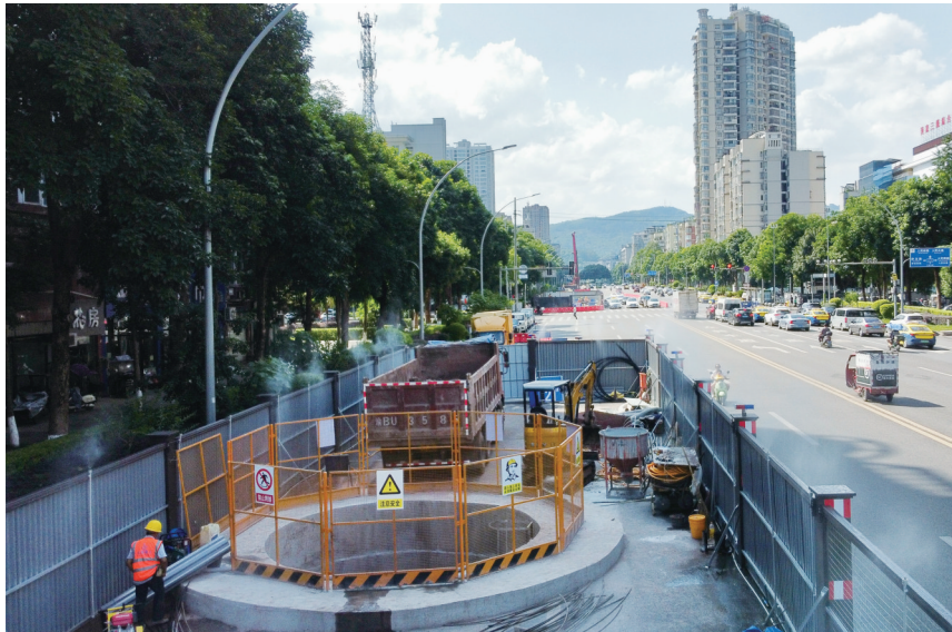
中山路街道污水管网更新改造工程(一期)非开挖施工工作井现场。
