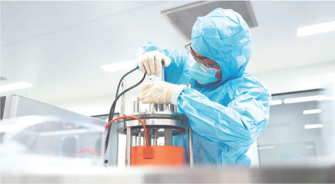
工作人员正在进行发酵罐安装。
