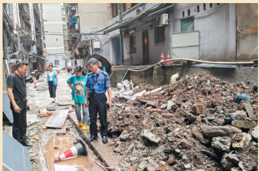
城管队员现场排险。
