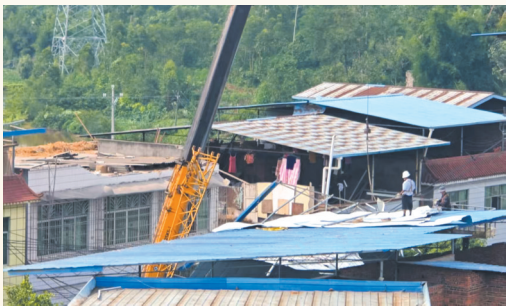
吊车固定彩钢防脱落。
