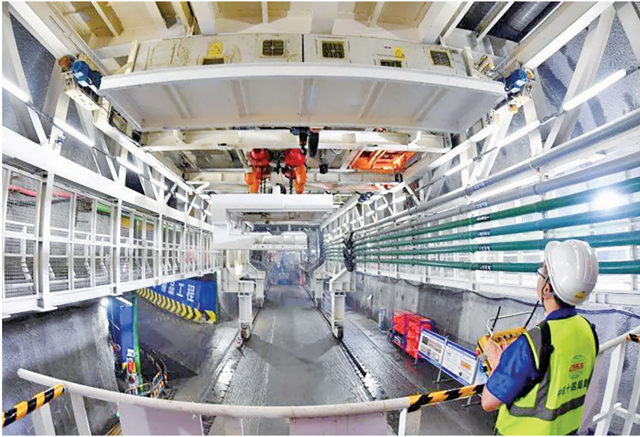
渝厦高铁重庆菜园坝长江铁路隧道建设现场。(中铁十四局集团供图)
