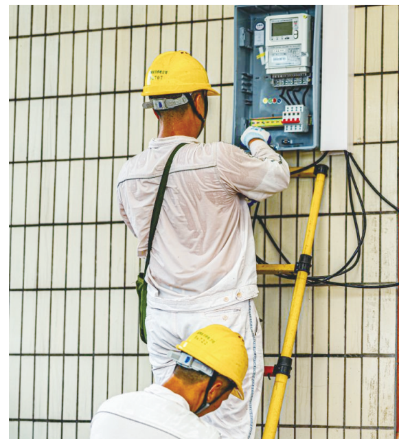
电力员工安装动力电表。
