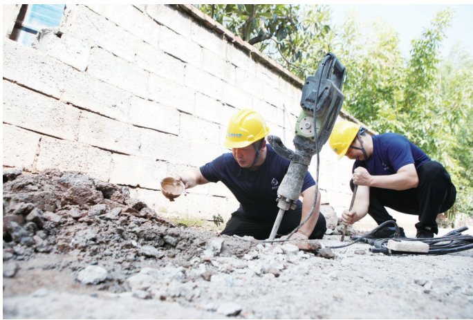
工作人员现场检修管道。
