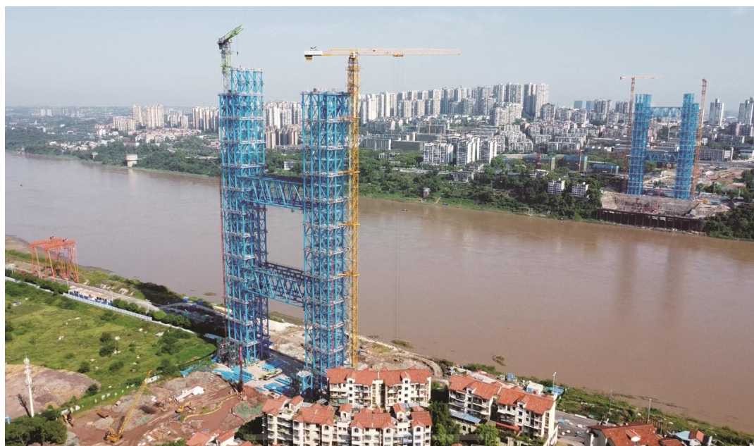
长江五桥建设稳步推进。
