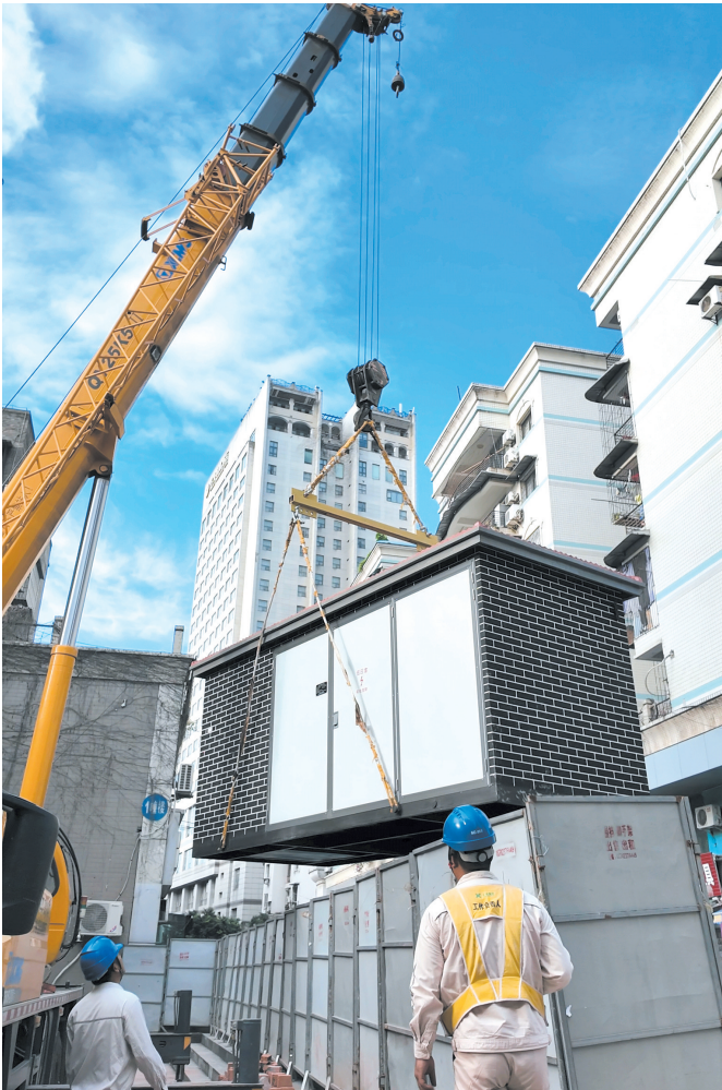
莹花小学安装变压器。
