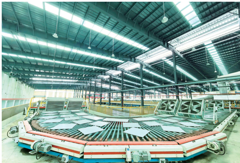
8月22日,重庆东鹏基地柔性制造生产线。
